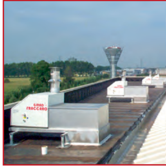
Dikey Çatı Uygulaması Roof installation
