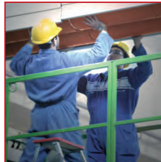
Montaj Ekibi Installation team
