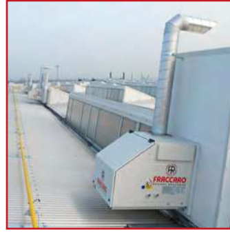
Yatay Çatı Uygulaması Shed installation
