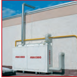
Dış duvar kurulumu Outdoor wall installation
