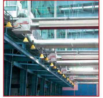
Tavan Uygulaması Ceiling installation
